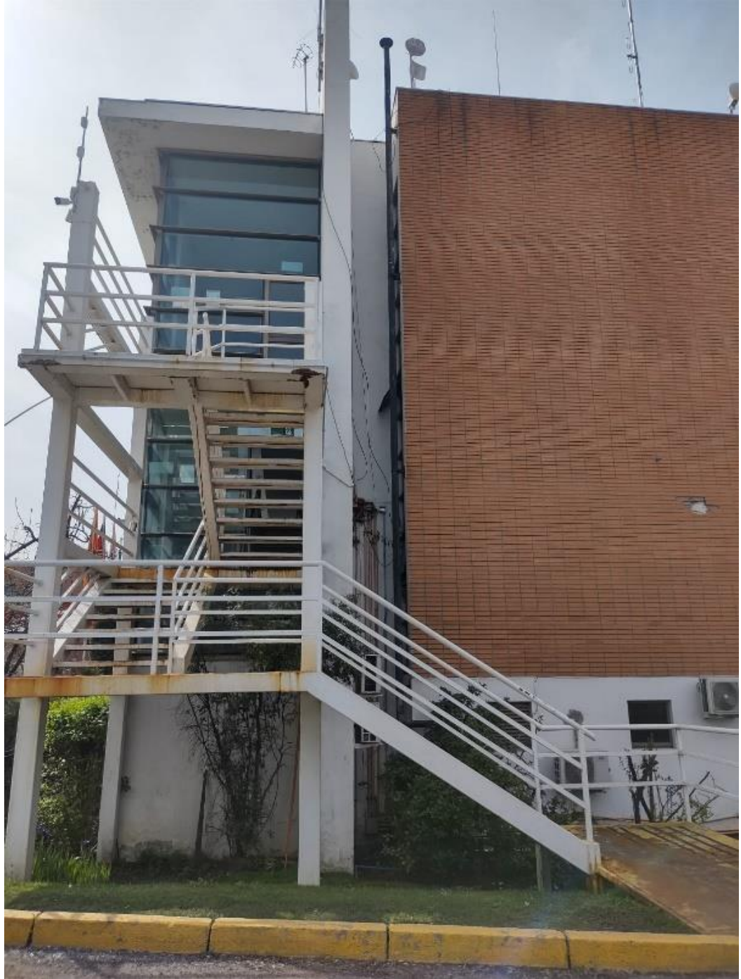
Escalera de Emergencia
